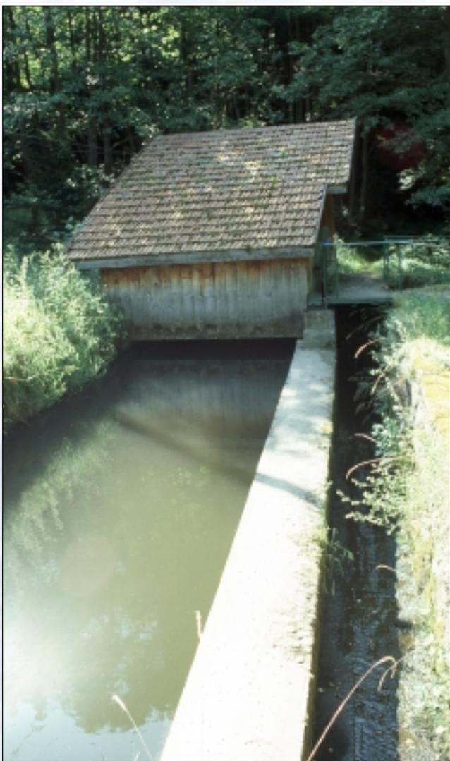
Einlaufkanal der Murg in das Rechenhaus. Dort beginnt dann das Betonrohr, welches das Wasser über 778 m Länge zum Wasserschloss führt. Rechts neben dem Einlaufkanal der schmale Überlauf, welcher zurück in die Murg führt.
