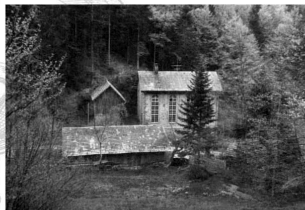
Das *Kraftwerk Hottingen im Gewann „Im Schlag“* wurde 1908 erbaut und lieferte aus einer *Francis-Turbine* ca. 220 kW (=300 PS) Strom über eine 1,8 km lange Freileitung an einen 135 PS starken 3000 V-Drehstrommotor, der die *Webstühle* antrieb
