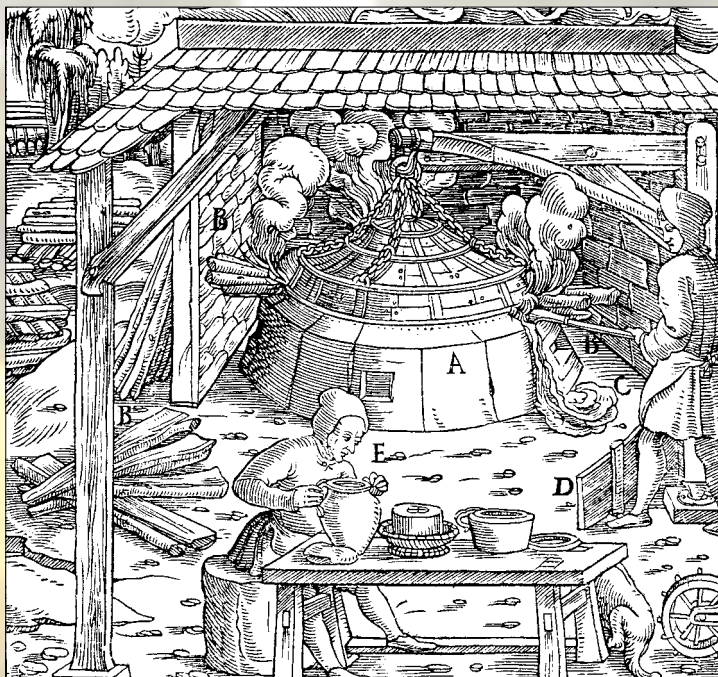
Treibofen. Der Mann im Vordergrund ißt Butter um sich gegen Vergiftung zu schützen
