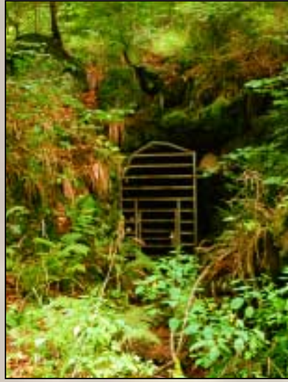
Stollenmundloch Grube Schwarzwaldsagen
